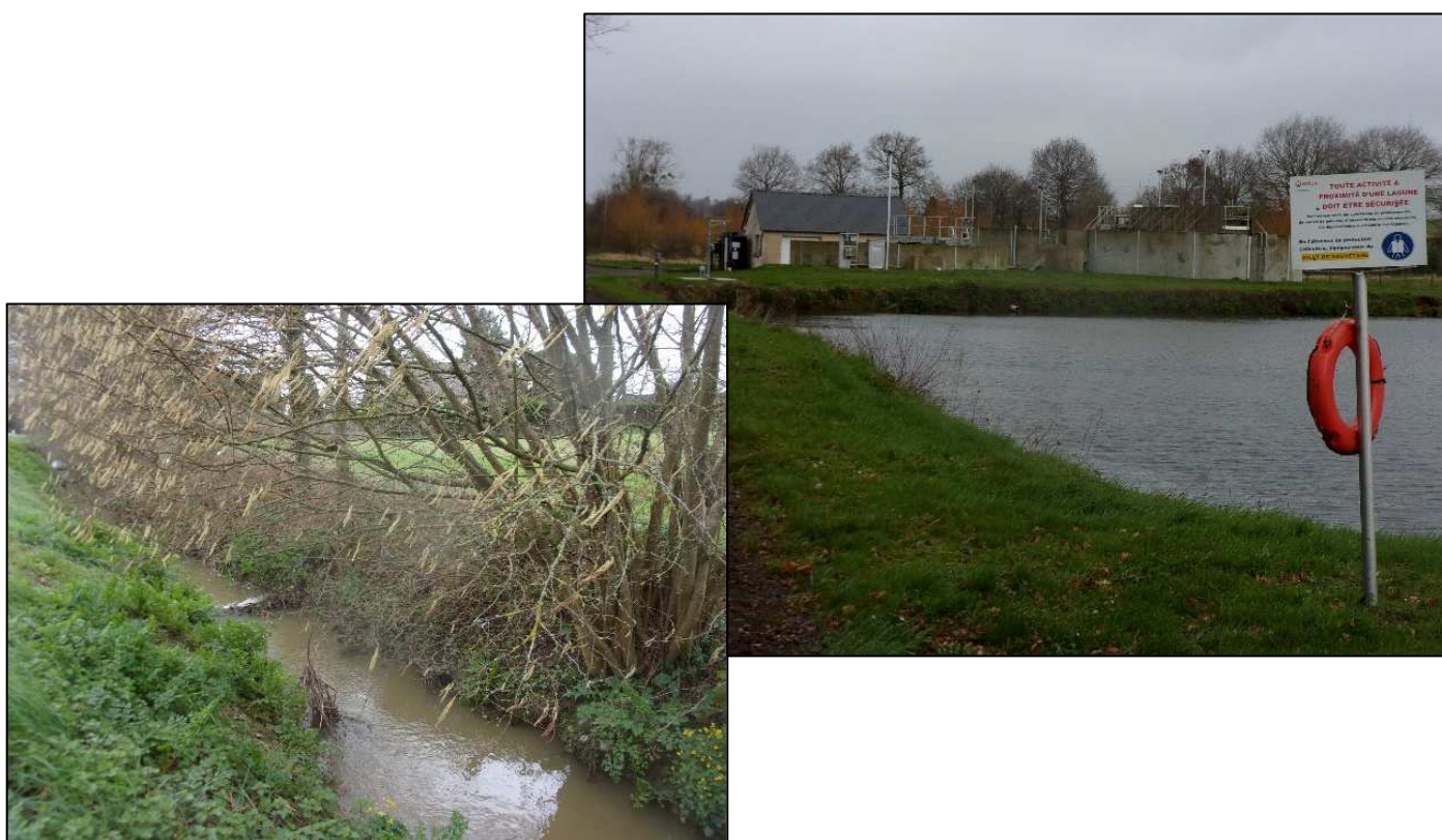
Figure 9 : Photos de la station d'épuration de « La Prairie d'Abas » de la Chapelle du Lou du Lac et du milieu récepteur, le ruisseau du Moulin du Lac.
