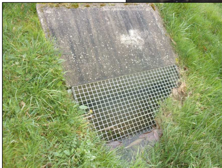
Photo 2 : Vue du bassin d'orage sud de la « Résidence du Lohat », ainsi que son ouvrage de sortie et sa cloison siphonoïde en sortie du bassin
